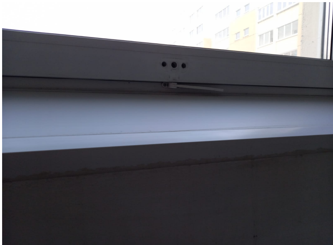
Установка ручки 1ый подъезд
