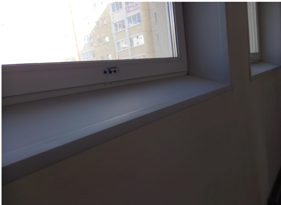
Установка ручки 1ый подъезд
