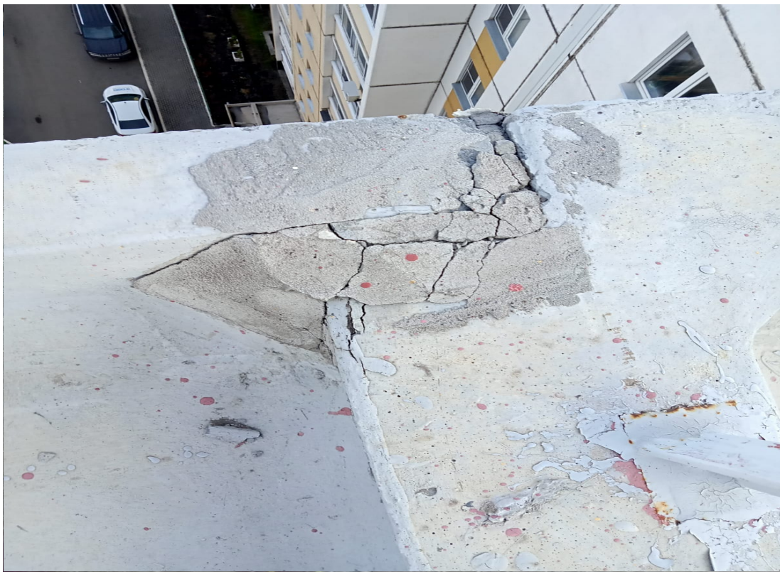
Локальный ремонт кровли
