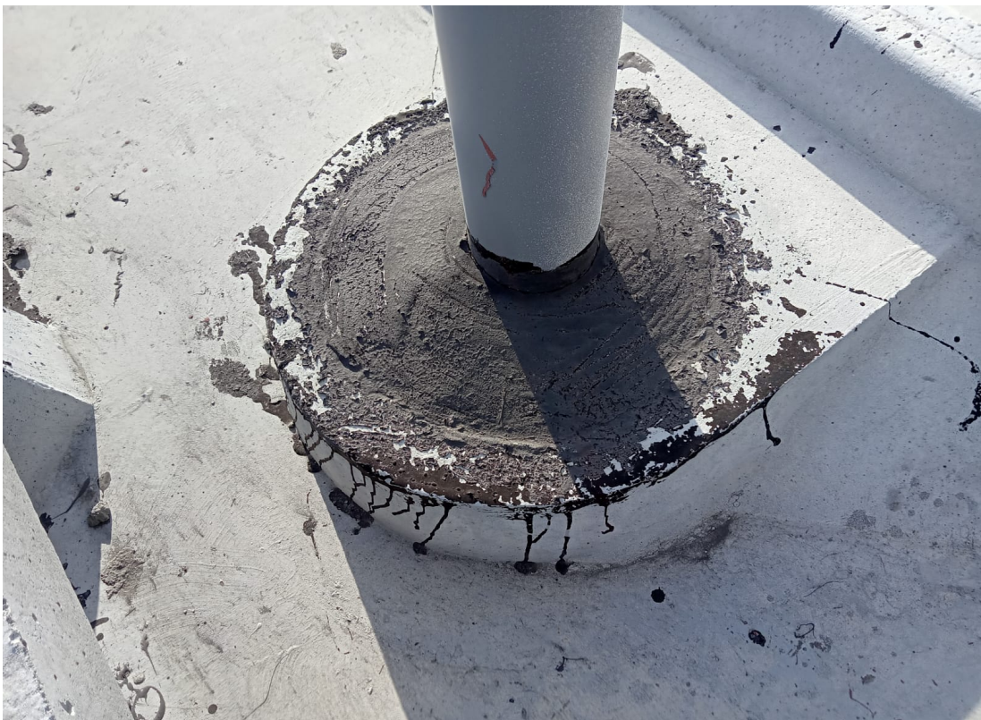
Локальный ремонт кровли
