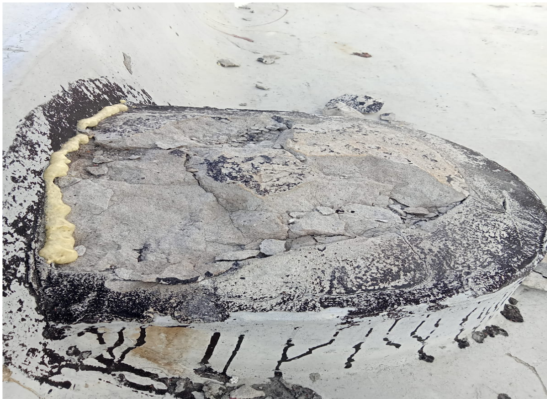
Локальный ремонт кровли
