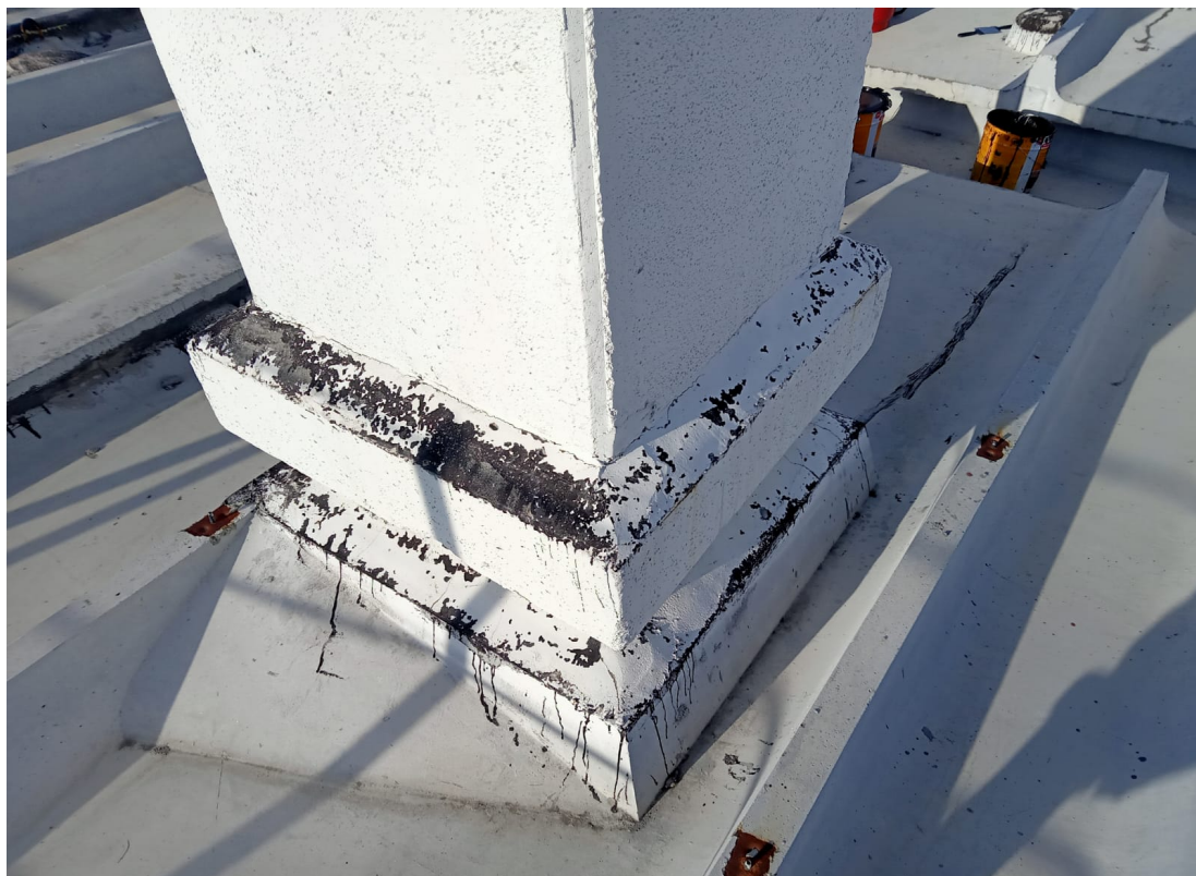
Локальный ремонт кровли
