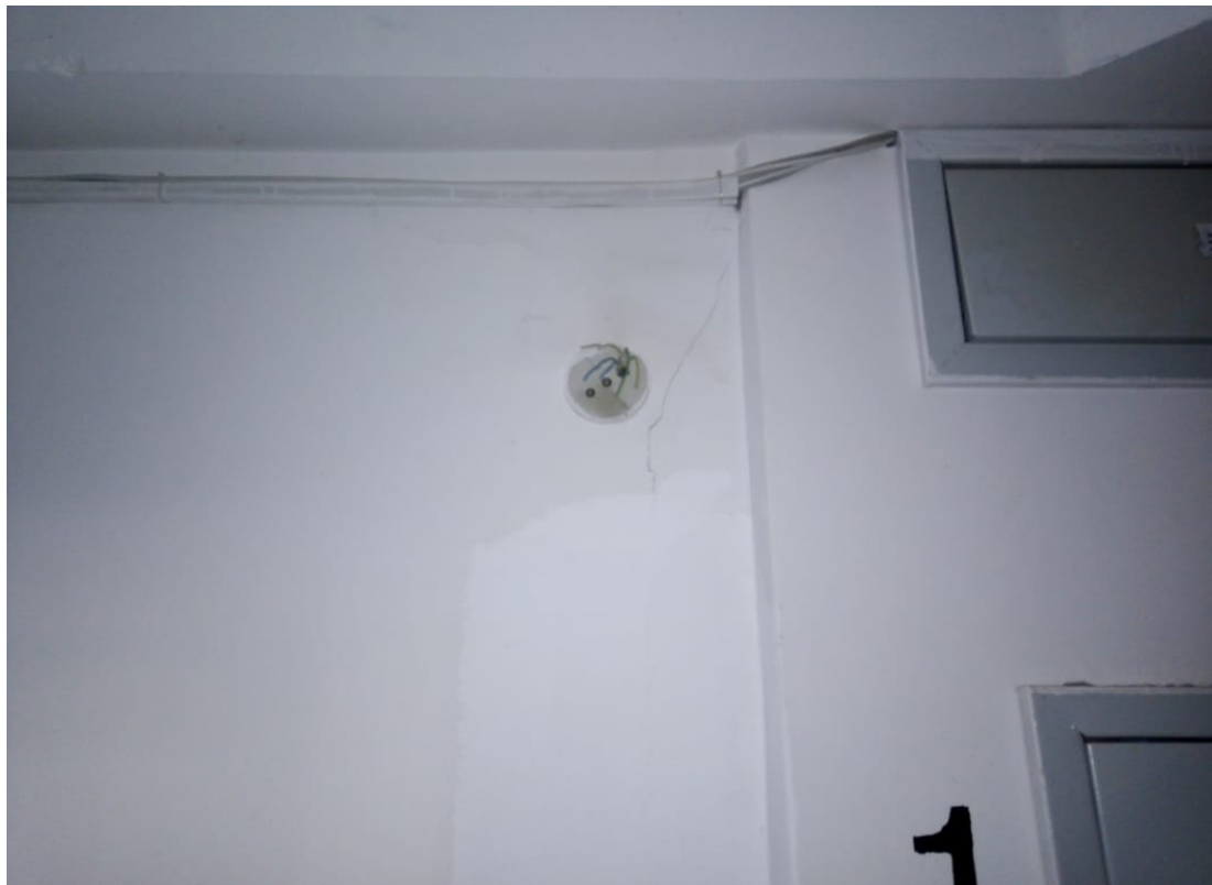
Замена светильника и лампочки
